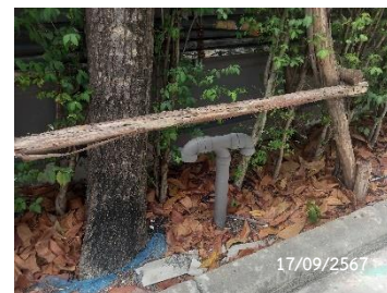
ท่อระบายอากาศของบ่อมีเทน
